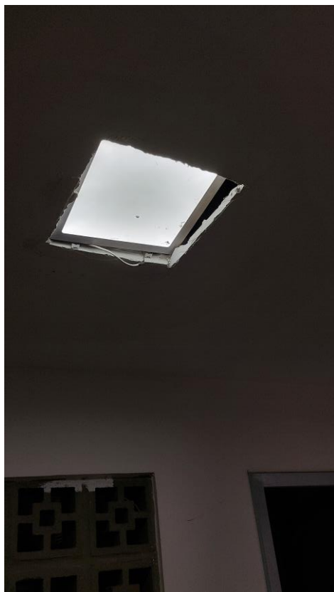
Aspecto do forro
