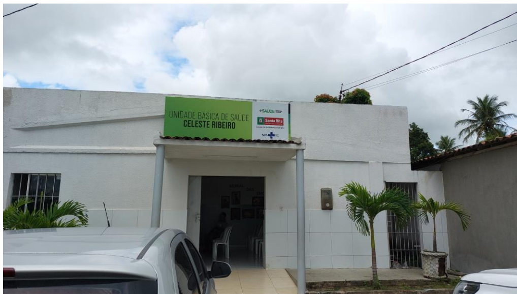
Fachada da unidade
